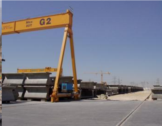
Fotografía 7.13 Doble acopio de dovelas en parque de prefabricación para metro de Dubai
