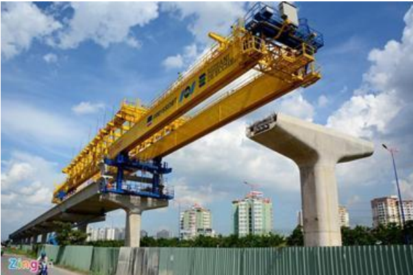
Fotografía 7.8 Viga lanzadora para viaducto en "U" del metro de Ho Chi Minh
