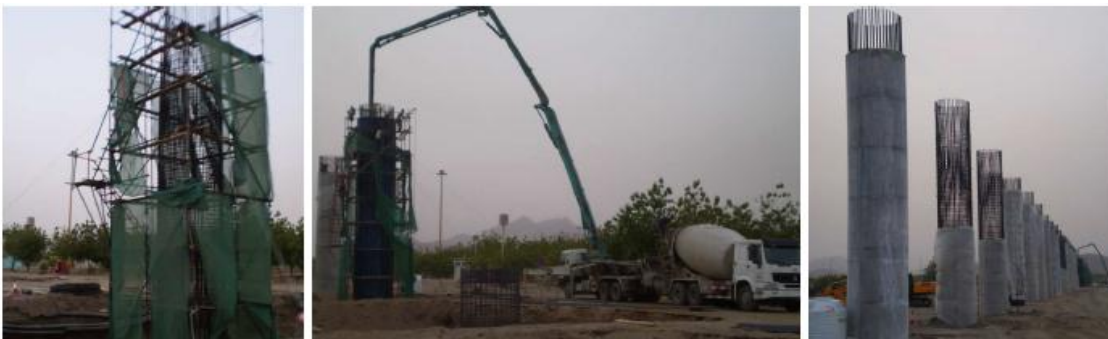
Fotografía 7.6 Ejemplos de construcción in situ de elementos de subestructura
