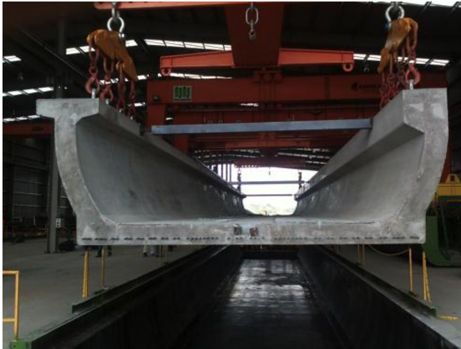
Fotografía 7.5 Vista 2 de parque de prefabricación para Metro de Panamá
