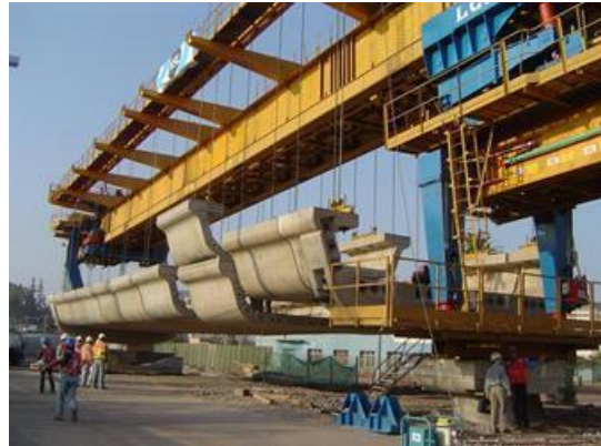
Fotografía 7.9 Izado de dovelas mediante viga lanzadora (metro de Delhi)
