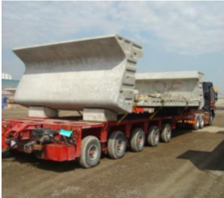
Fotografía 7.14 Transporte de dovelas del parque a obra mediante camión - remolque
