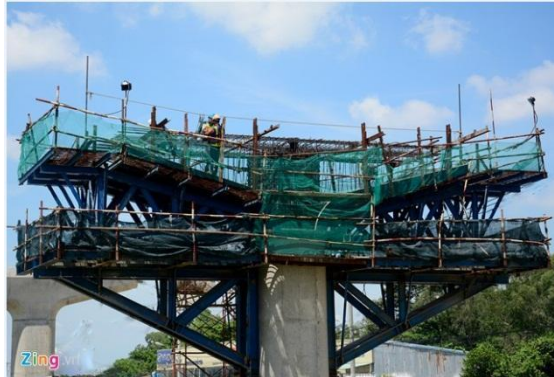
Fotografía 7.7 Construcción de capitel in situ
