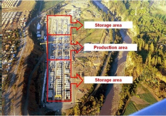
Fotografía 7.3 Vista de parque de fabricación para Línea 4 de Metro de Santiago de Chile
