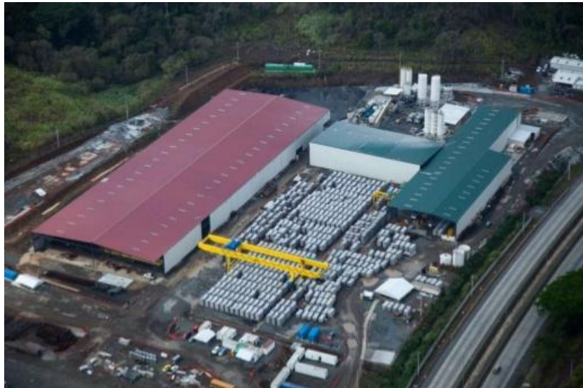
Fotografía 7.4 Vista 1 de parque de prefabricación para Metro de Panamá - Fuente. Metro de Panamá.
