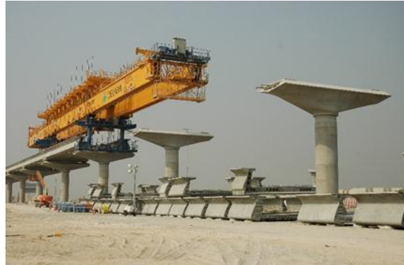
Fotografía 7.15 Acopio de dovelas en obra previo a montaje con viga lanzadora
